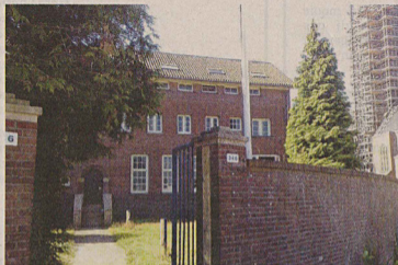
De ingang van het zusterhuis, deeluitmakend van het Klein Seminarie. Met een muur werd het zicht op de nonnen ontnomen. foto Jeroen Pol
